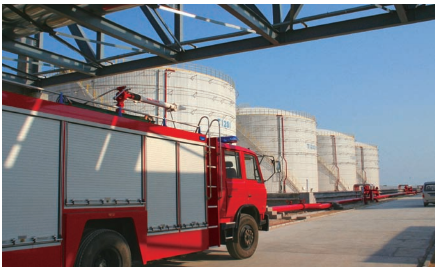
储油灌区消防演练
